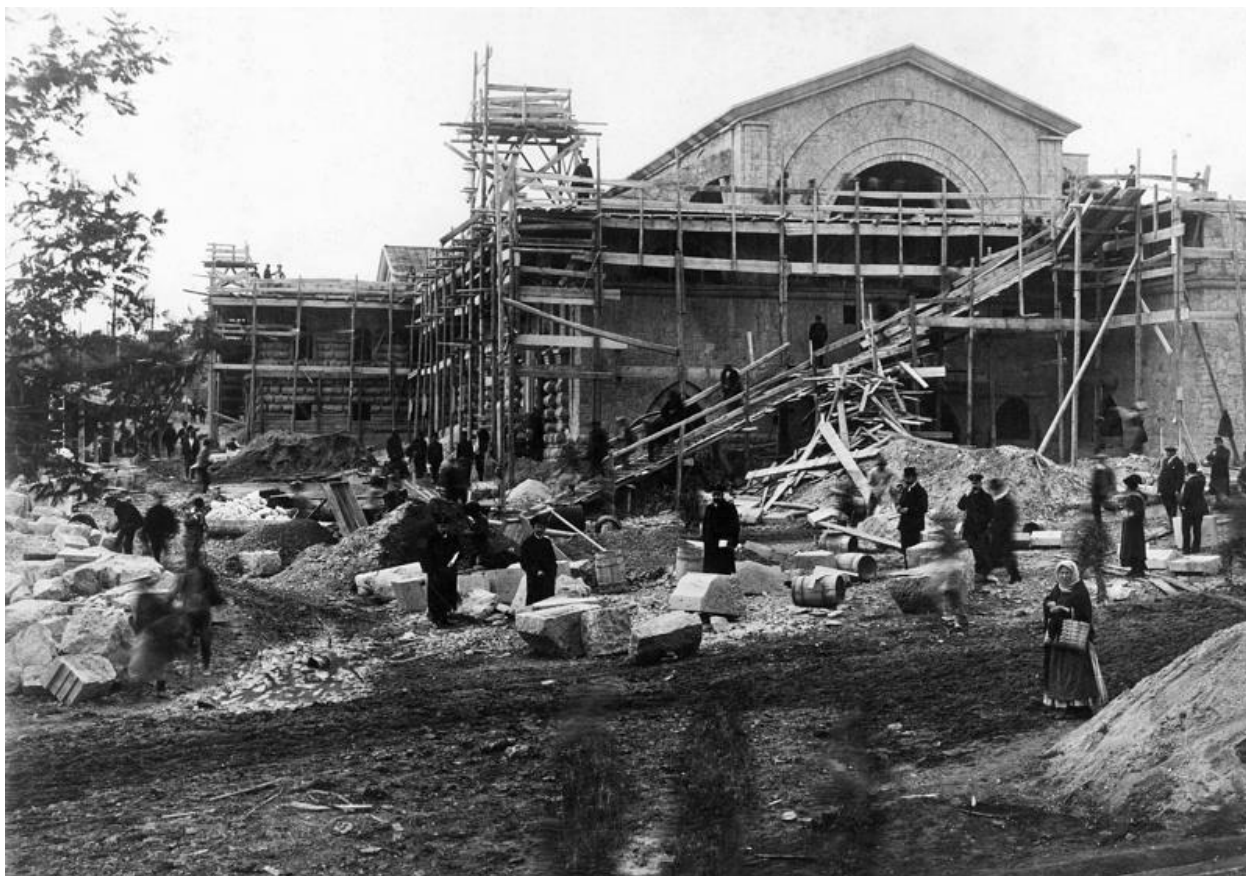
Рисунок 2.4.9. Строительство грязелечебницы. 1915 г. 23
