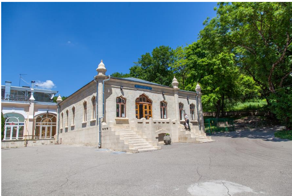
Рисунок 2.4.2. Памятник архитектуры федерального значения «Галерея над источником №17». Лечебный парк г. Ессентуки 18
