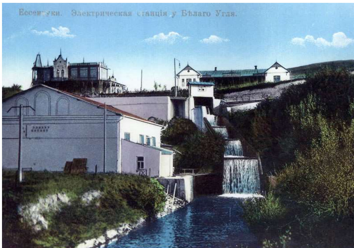
Рисунок 2.4.7. Историческое здание ГЭС «Белый уголь». 1903 г. 22
