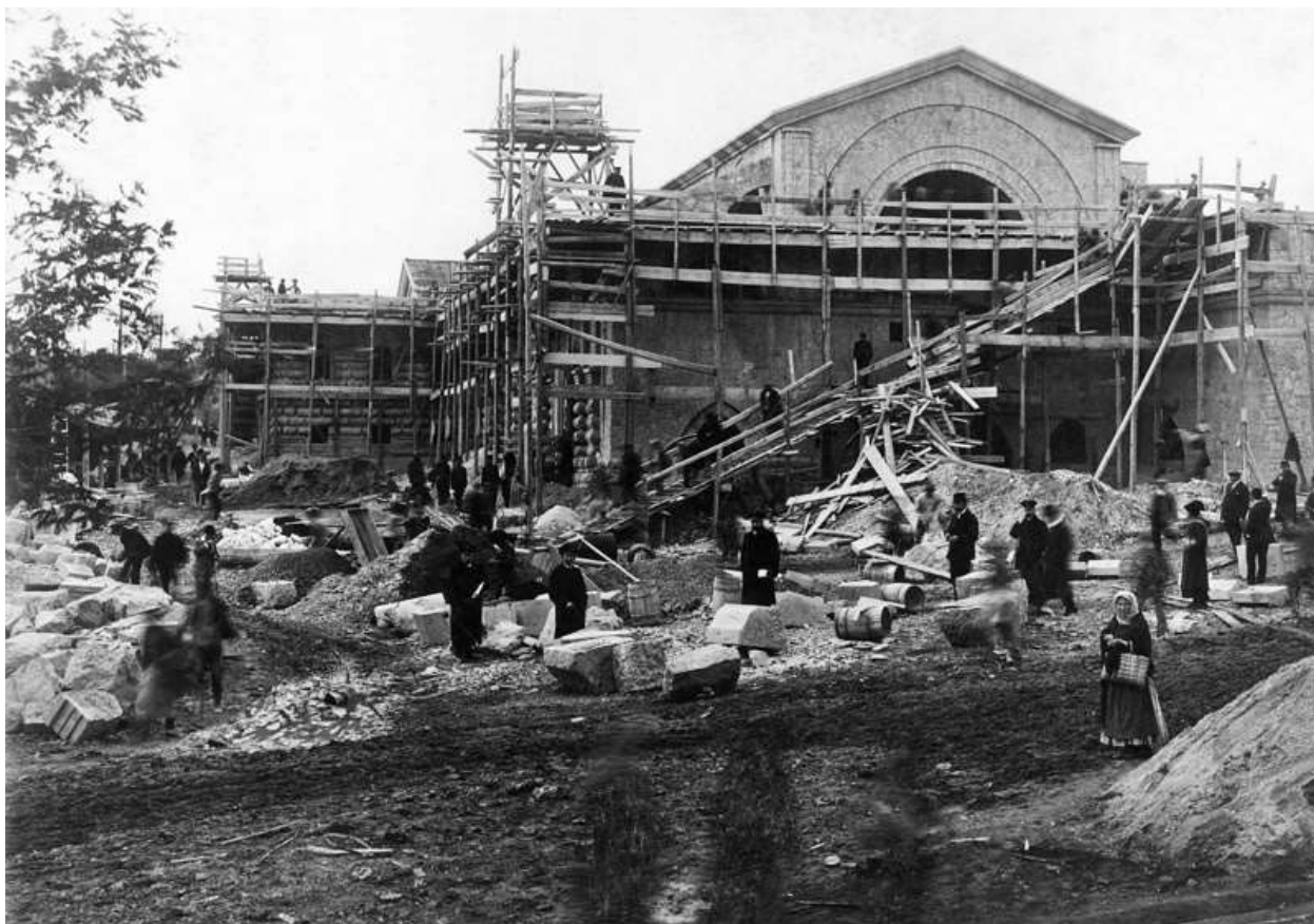
Рисунок 2.4.9. Строительство грязелечебницы. 1915 г. 23
