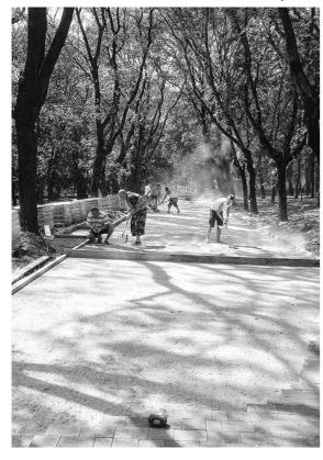
Работы по благоустройству Курортного парка идут полным ходом. Уже завершен демонтаж кабеля и опор уличного освещения, монтаж плитки, ливневых канавок, инженерных коммуникаций на нескольких аллеях.
