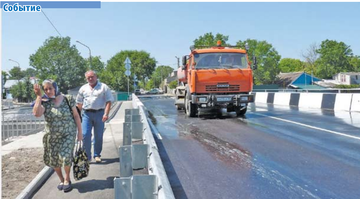
Новый мост через р. Бугунту
