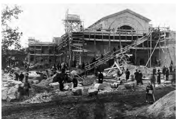
Рисунок 2.4.9. Строительство грязелечебницы. 1915 г. 23
