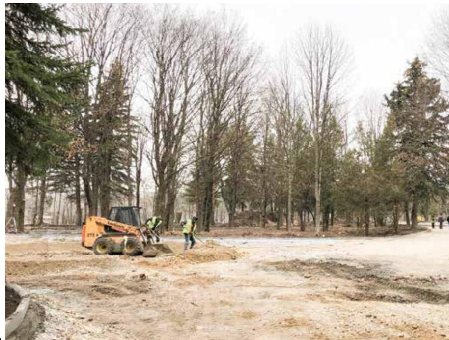
Эссентуков, выполнение работ составляет 40%. Продолжается вертикальная планировка территории, выполняются установка аллея бортового камня, устройство основания аллеи, укладка геотекстиля и др.
