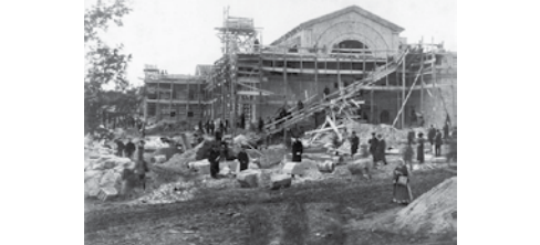
Рисунок 2.4.9. Строительство грязелечебницы. 1915 г. 23
